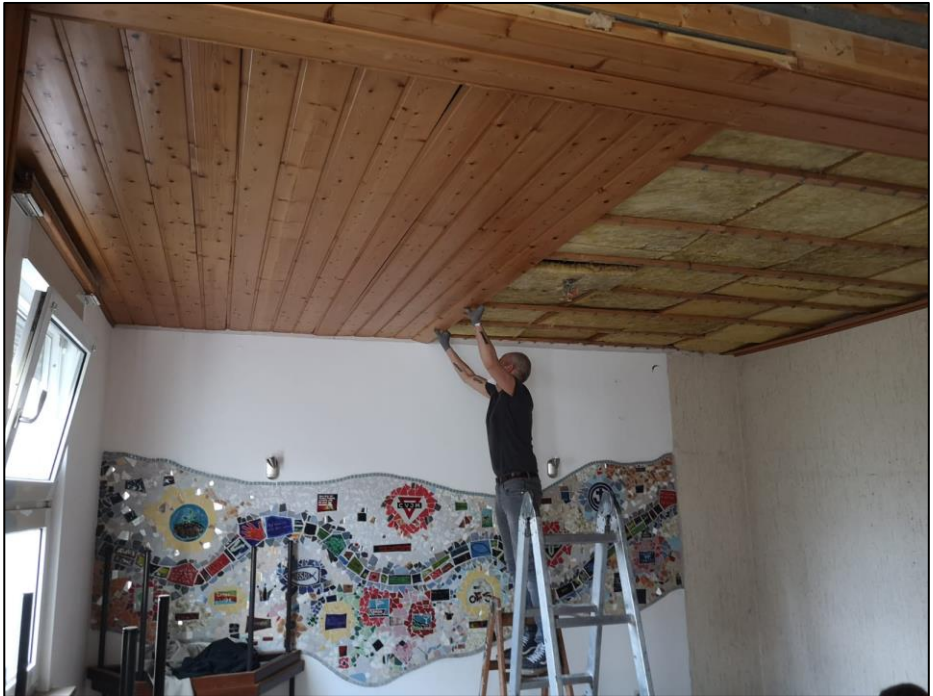
Abriss der 35 Jahre alten Holzdecke. (Foto: Julian Ahlers)
